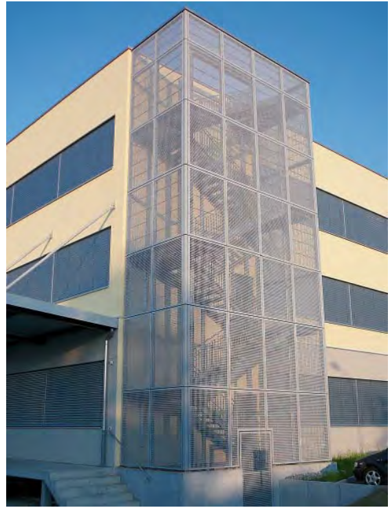
Treillis métallique: laisse passer la lumière, économique et sans danger pour les oiseaux.
