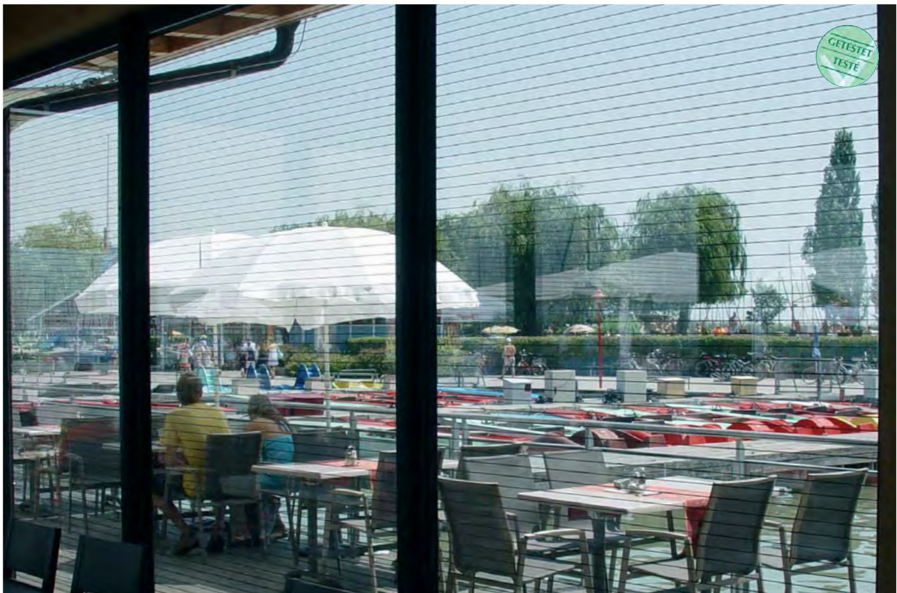
La vue vers l'extérieur n'est pas gênée par les fines lignes du verre de protection des oiseaux. Le dessin épargne aux clients d'avoir à supporter des oiseaux morts.
