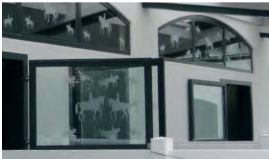
Dans l'élaboration de ce décor original d'un manège, la règle de la paume d'une main n'a malheureusement pas été entièrement respectée.
