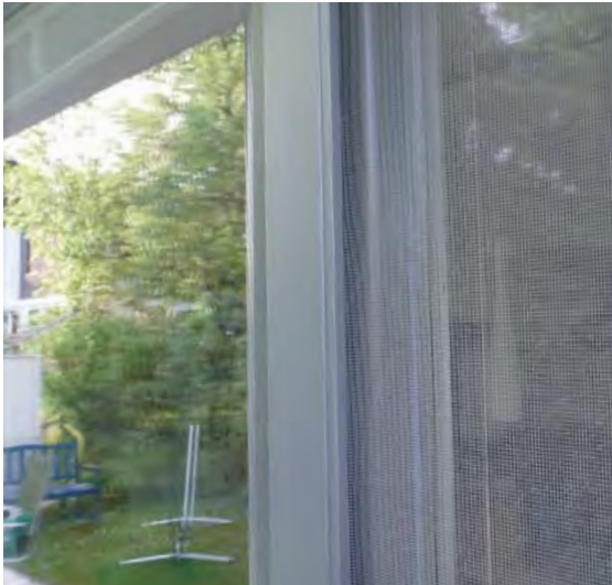
La fixation d'une moustiquaire à l'extérieur de la vitre (fenêtre de droite) réduit fortement les réflexions.
