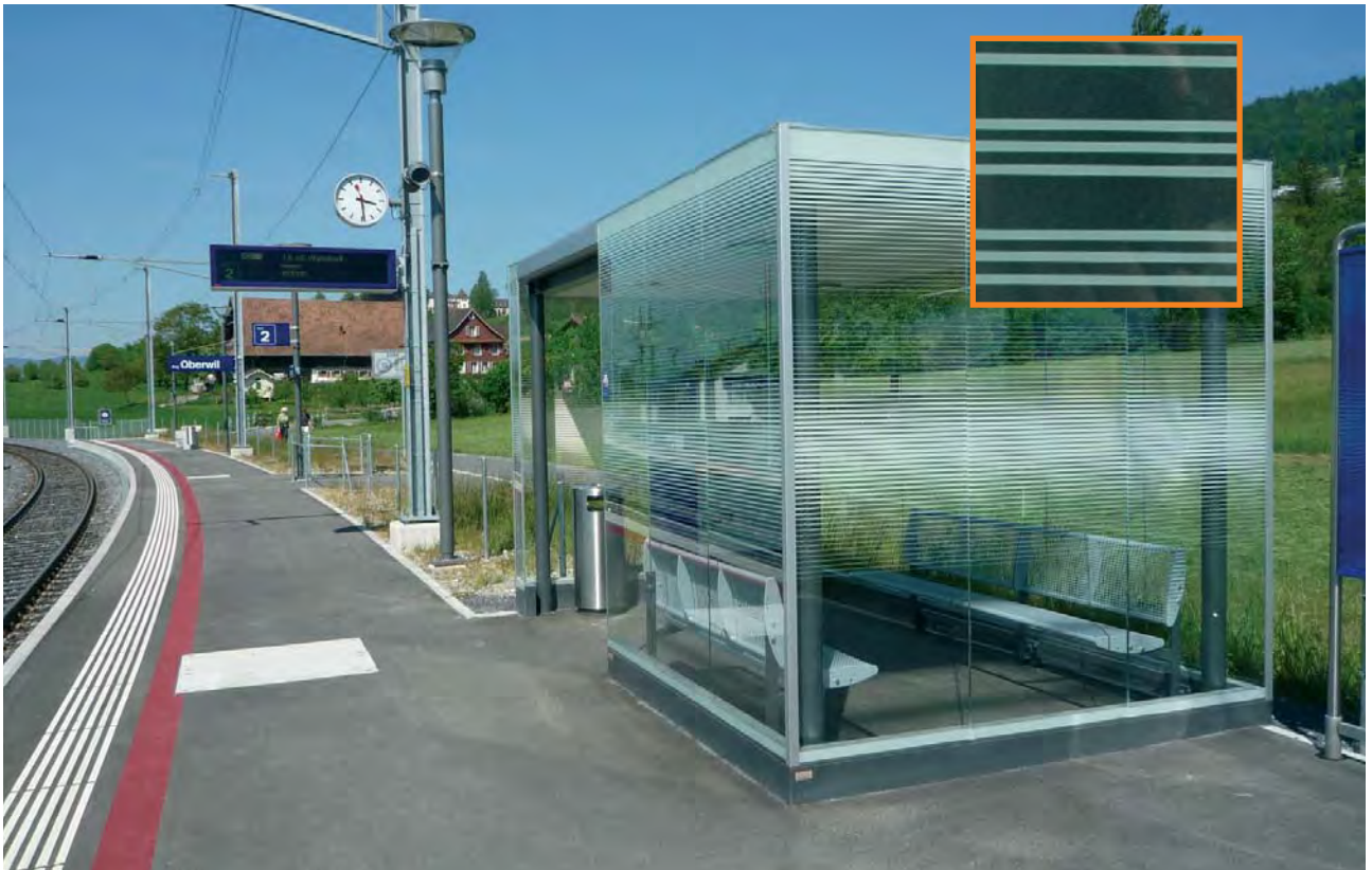
Nouveau standard pour les salles d'attentes des chemins de fer fédéraux suisses. Il a été renoncé aux marquages à proximité du sol. La transparence y est coupée par l'aménagement intérieur.
