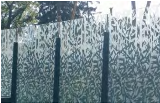
Paroi antibruit: efficace malgré le motif végétal.
