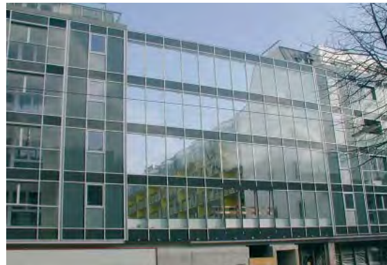
Paroi antibruit et coupe-vent entre deux bâtiments
