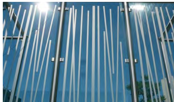
Il n'est pas obligatoire d'appliquer la trame de lignes de façon strictement verticale.
