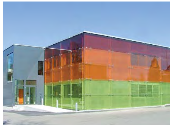
Poste de police innovateur : quasi pas de zones problématiques pour les oiseaux.
