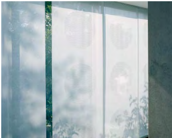
Les rideaux qui laissent passer la lumière sont mieux que les rideaux obscurcissants, car on les laisse toujours tirés. Mais ils ne sont efficaces que pour du verre peu réfléchissant.
