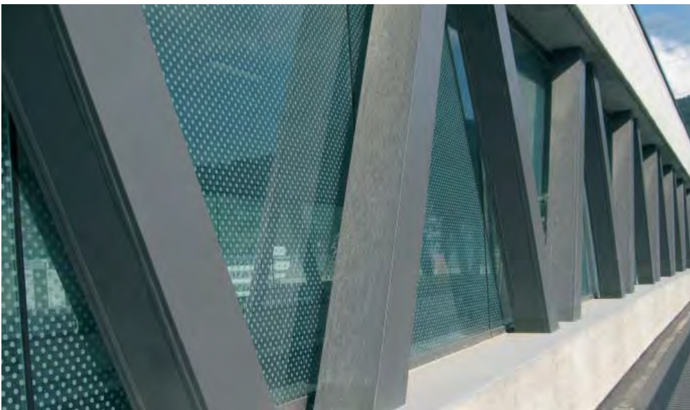
Nouveau pont d'une bretelle d'autoroute : les vitres ont été munies sur toute la longueur d'un motif de points blancs relativement grands.
