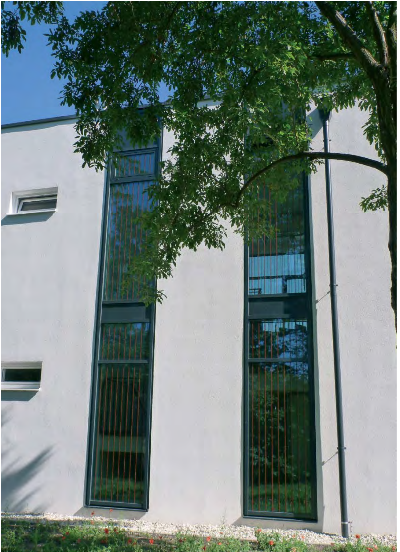
Certains des marquages ayant obtenus de très bons résultats en tunnel de vol sont déjà appliqués sur le verre directement à l'usine. Cela évite de devoir les apposer après coup sous forme de film adhésif.
