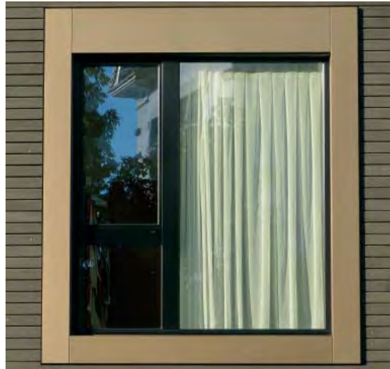
Des rideaux clairs pendus directement derrière la vitre peuvent parfois réduire les réflexions de façon spectaculaire.
