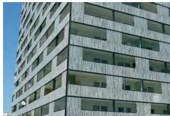
Ce verre sérigraphié met les utilisateurs à l'abri des regards et rend l'obstacle visible aux oiseaux.
