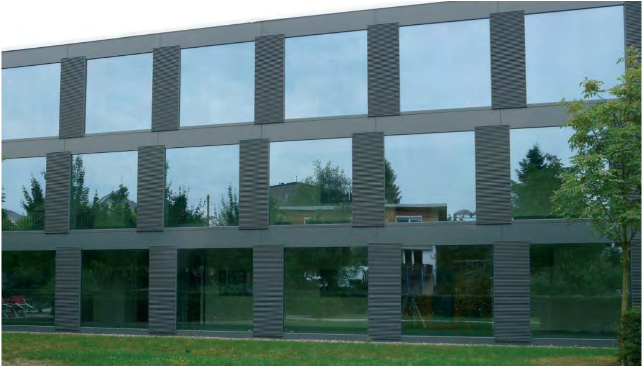
Grande façade, forte réflexion, au milieu d'un quartier très vert – un piège mortel qui ne peut pratiquement plus être désamorcé après coup, ne serait-ce qu'en raison de l'aspect financier.
