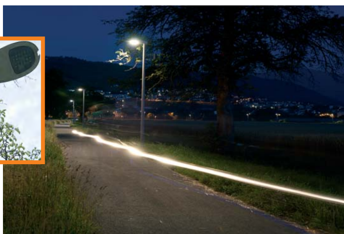
Un chemin pour piétons et vélos équipé des luminaires les plus modernes couplés à des détecteurs de mouvement. La lumière devient plus intense au passage d'un cycliste.
