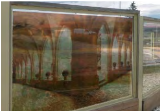
Motif historique sur film, laminé à l'intérieur du verre. Malheureusement les éléments adjacents sont restés transparents.
