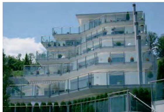
Dans ce lotissement, l'intégralité des balustrades de balcon et autres barrières a été réalisée en verre transparent.
