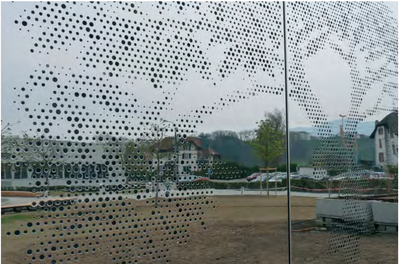
Cette façade composée de panneaux métalliques fortement réfléchissants pose un problème aux oiseaux. Le motif composé par les trous réduit un peu le danger de collision. Il reste toutefois de trop grandes surfaces libres de tout motif où le risque de collision est élevé.
